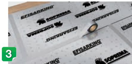
3 Pontage des joints avant la mise en œuvre des contrelattes avec **Efibande Butyle**.
