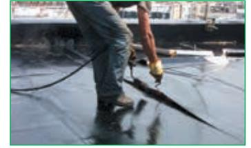
3. Soudage des joints de recouvrement de la première couche d'étanchéité.
