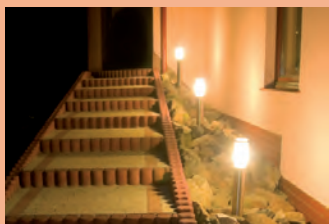
réseaux électriques d'extérieur (portail, éclairage...)
