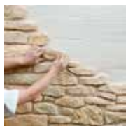
1 - Je pose en croisant les joints d'une rangée sur l'autre
