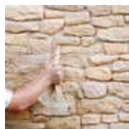
2 - Je réalise les joints
