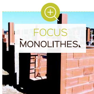
L'utilisation de l'angle monolithe permet un gain de temps pour la réalisation des angles et simplifie le contrôle de la dalle.
