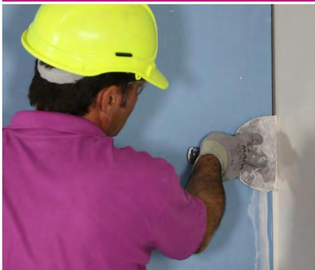
Procédez au garnissage, à la pose puis au serrage de la bande à joint PRÉGY (1,5m/m<sup>2</sup>). Terminez le remplissage et la finition (0,35 kg/m<sup>2</sup>(\*) d'enduit PRÉGY)
