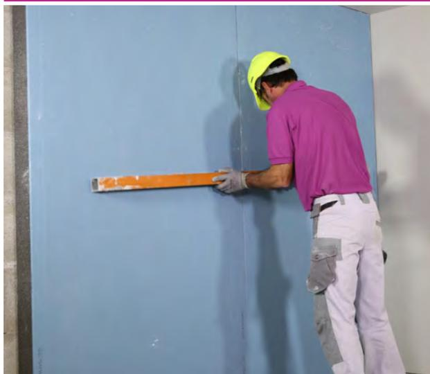
Alignez à la règle plusieurs panneaux à la fois sur le mur jusqu'à ce qu'ils affleurent les tracés (sol et plafond)
