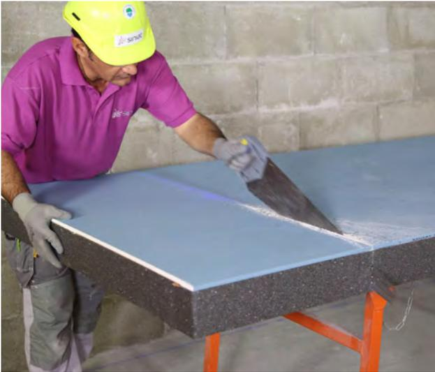
Découpez les plaques à la hauteur sol / plafond, diminuée de 10 mm, avec une scie égoïne ou électrique
