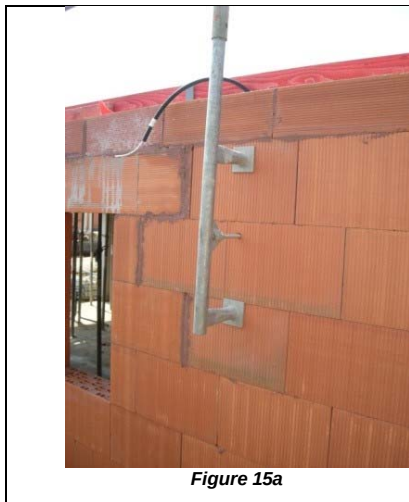
Figures 13 – Fixation des éléments de sécurité périphériques au niveau de l'avant dernier rang de maçonnerie
